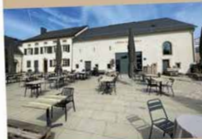
„An Henkes“, beispillhaft restauréiert.
